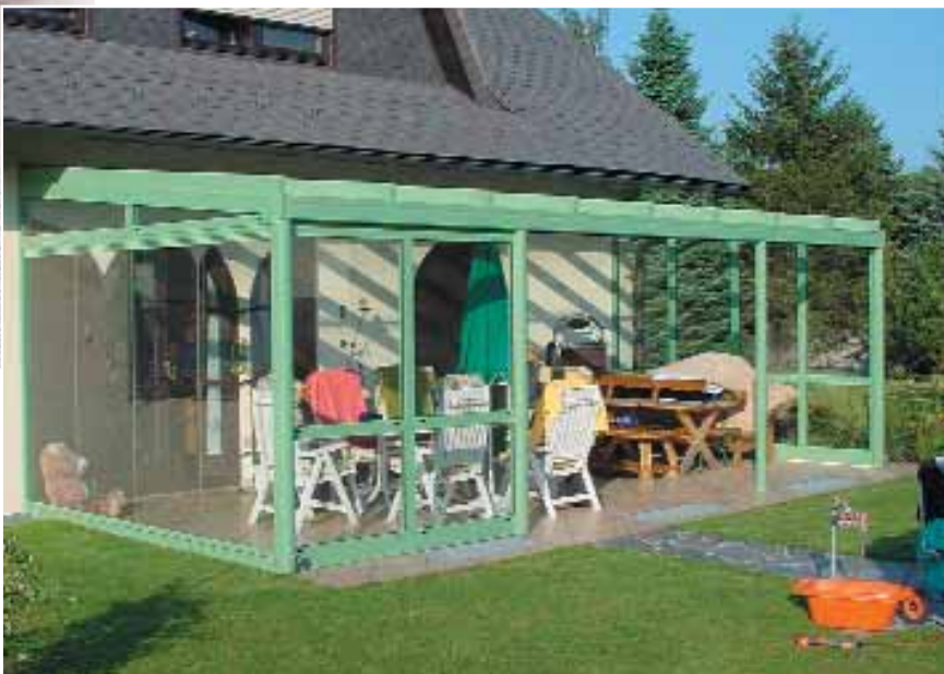
Terrassendach mit Windschutzelementen und Brüstungsfeld
