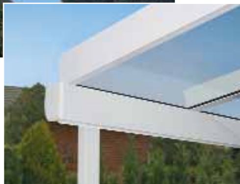
Trägeranschluss mit Rinnenabschluss
