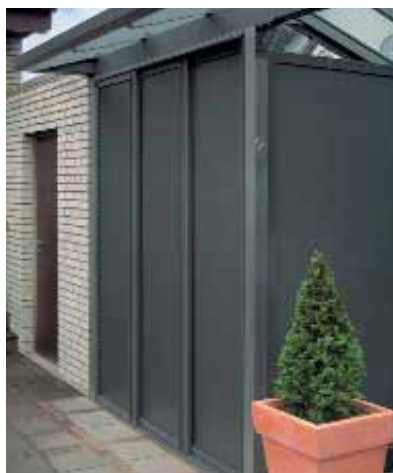
Geschlossene, dreispurige Schiebeanlage mit Füllungsplatten
